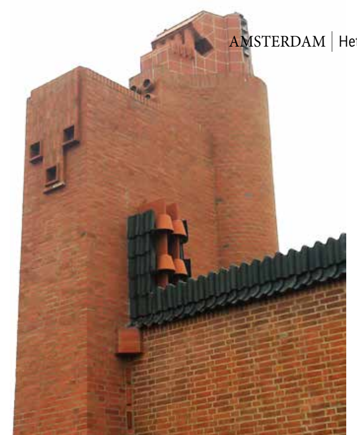
De gerestaureerde voorgevel van Het Schip waar het metselwerk is hersteld.
