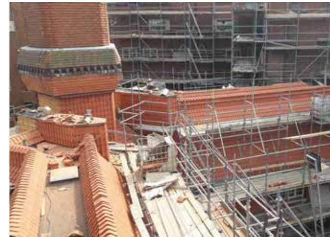
De nieuwe dakpannen hebben weer het originele formaat.
